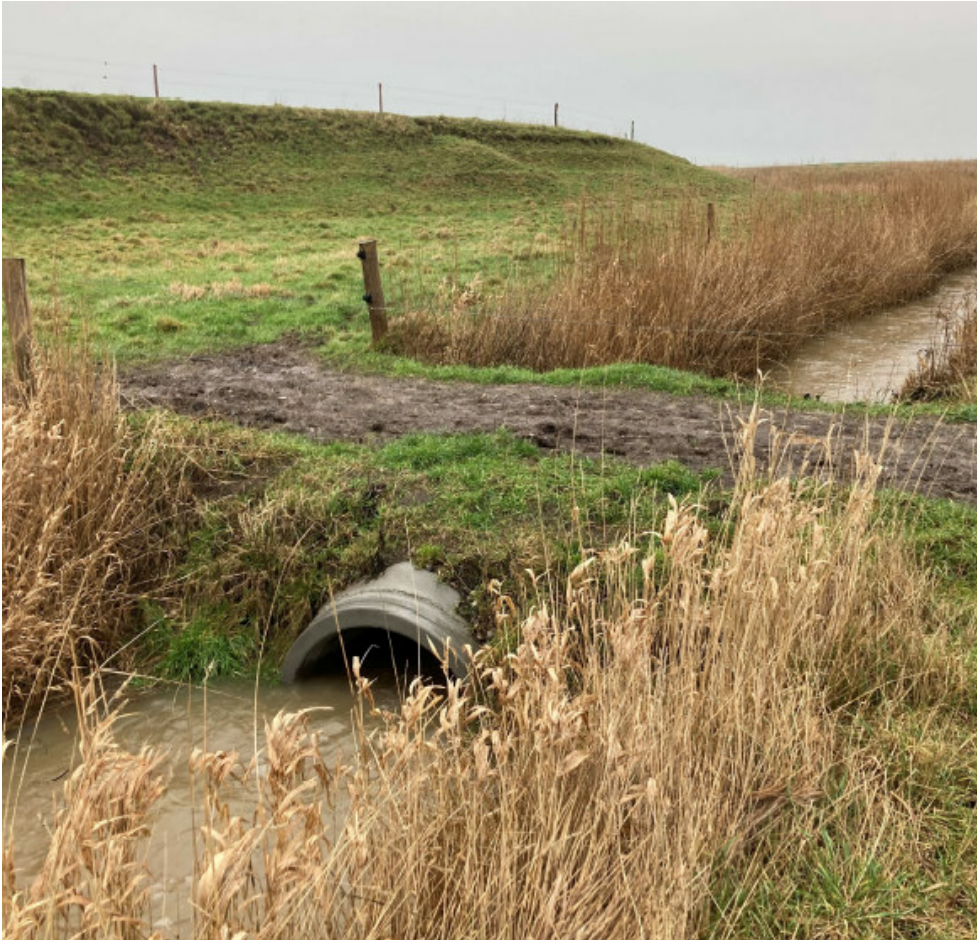
Figur 2: Foto af rørbroen der allerede er etableret
